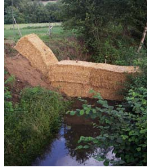
Simple barrage du ruisseau permettant une surverse d'eau claire
