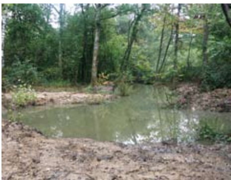
Dérivation en méandres avec une surverse en sortie
