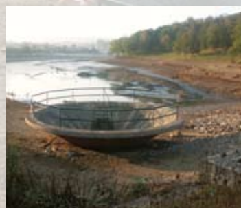
Le déversoir d'orage
