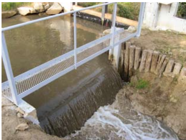
Pendant la vidange, les eaux chargées de sédiments sont détournées vers les bassins
